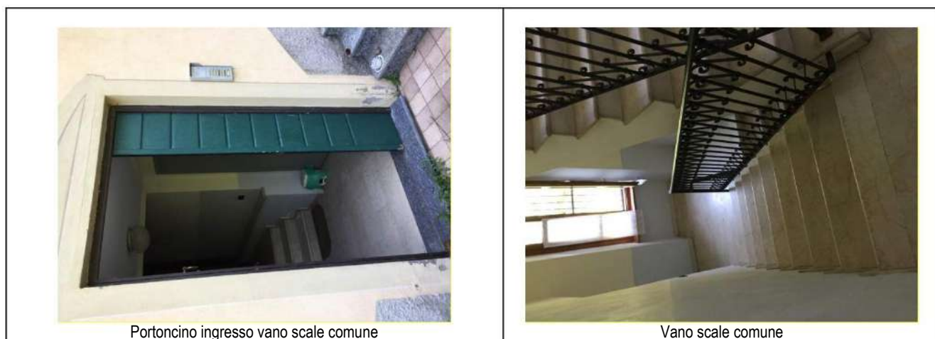
Figura 19: finiture del fabbricato
