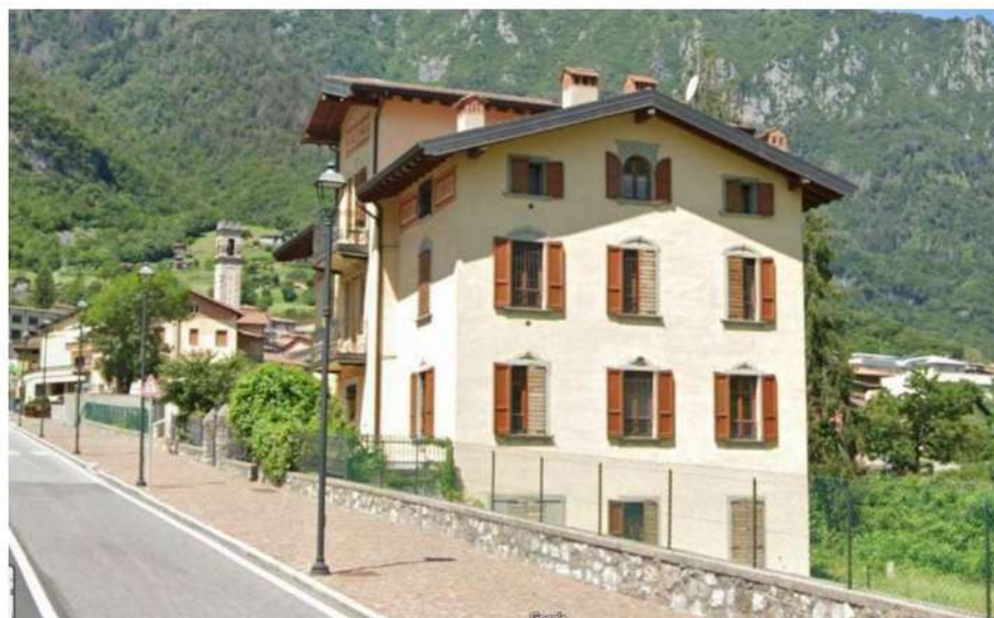
Fig. 05: Vista dell'edificio da Via Regina Elena - fonte google maps
