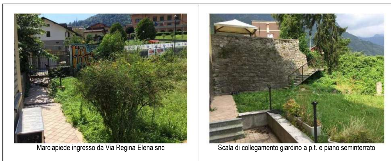
Figura 23: Percorso accesso pedonale
