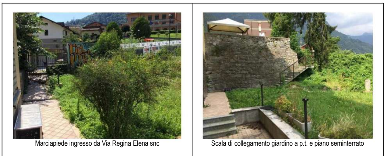
Figura 23: Percorso accesso pedonale
