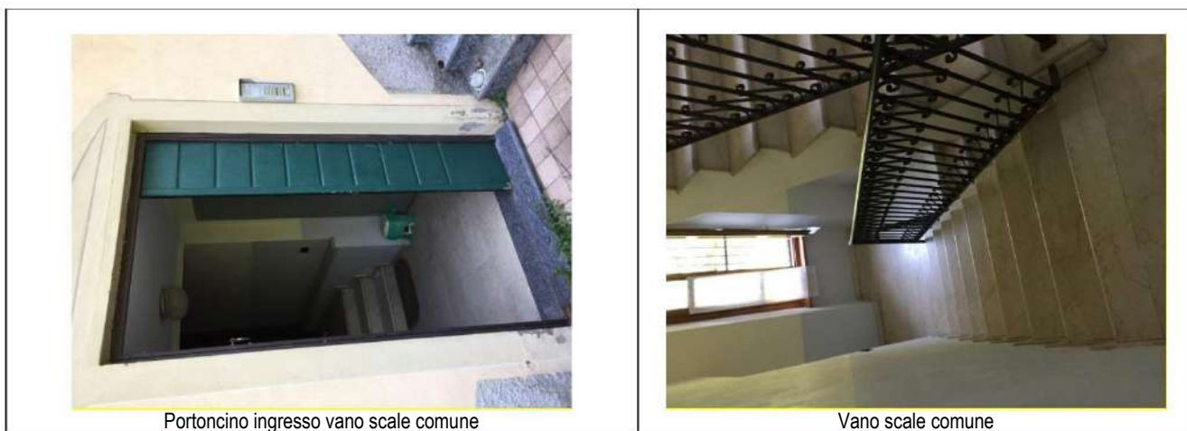
Figura 19: Finiture del fabbricato
