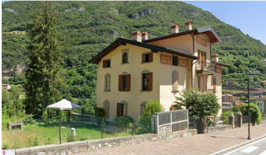
Fig. 04: Vista dell'edificio da Via Regina Elena - fonte google maps
