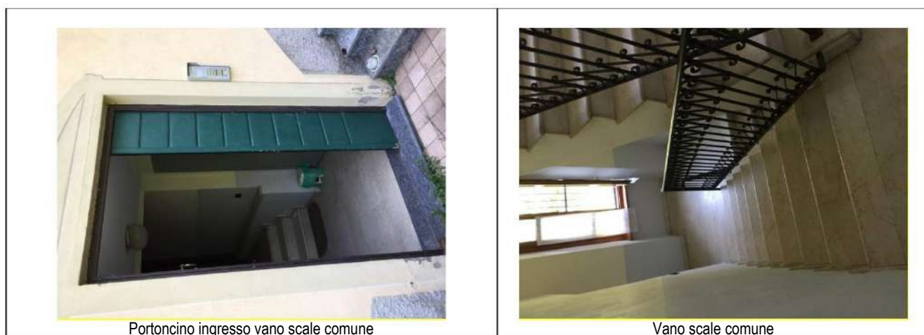
Figura 19: finiture del fabbricato
