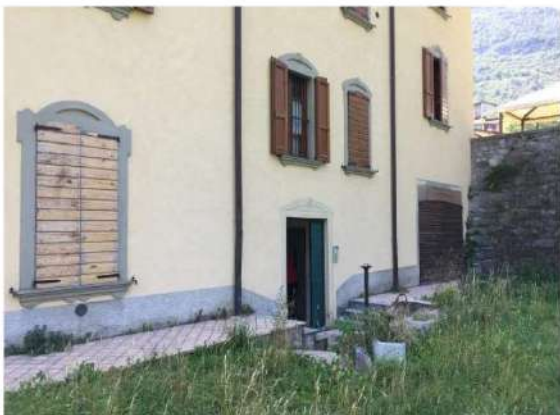
Fabbricato lato nord e ingresso al vano scale comune
