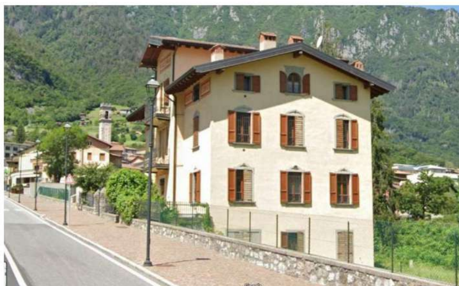
Fig. 05: Vista dell'edificio da Via Regina Elena - fonte google maps
