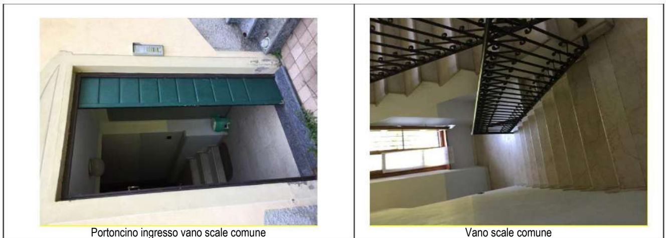
Figura 19: Finiture del fabbricato
