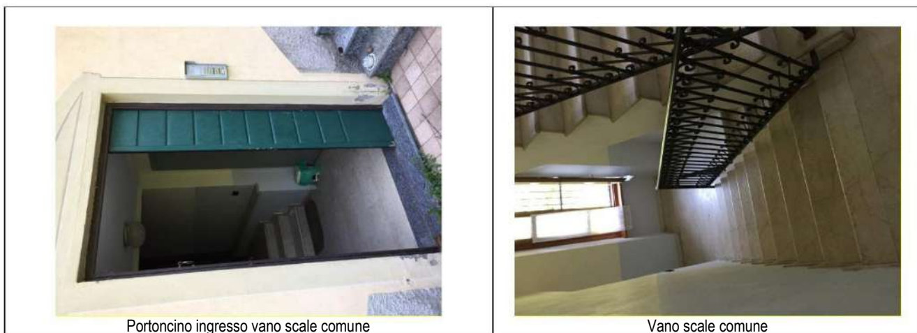
Figura 18: finiture del fabbricato
